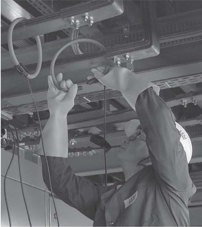
Fig. 40 Typische LEM-flex-Anordnung mit Umwicklung der Stromleiter
